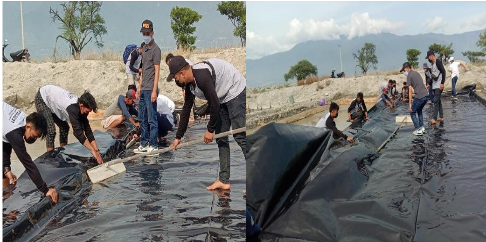
Gambar 4 Pemasangan Pelastik Geomembran LDPE
