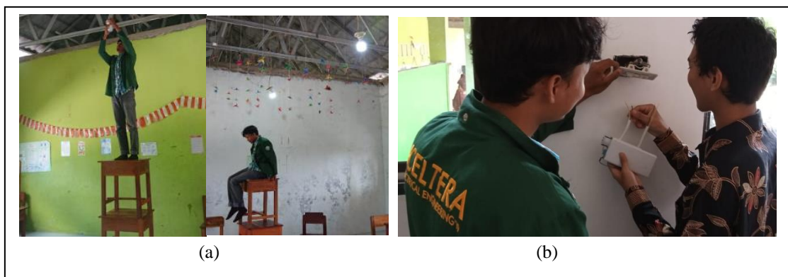
Gambar 6. (a) Pemasangan lampu dan (b) Pemasangan alat IoT oleh mahasiswa
