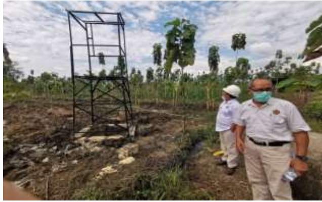
Gambar 9. Pemasangan Rangka Tandon dan Panel Surya
