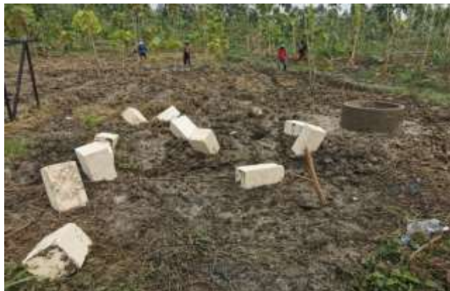
Gambar 8. Proses Pembuatan Sumur Resapan
