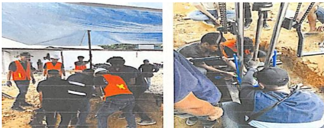
Gambar 3. Dokumentasi Hasil Uji Sondir Titik 1
