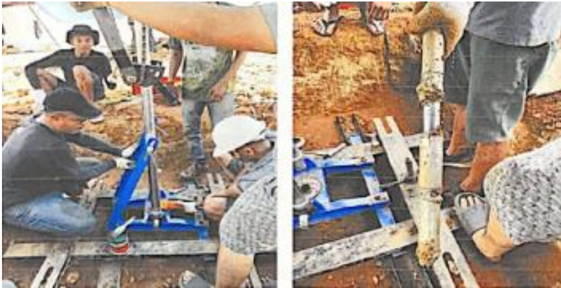
Gambar 5. Dokumentasi Hasil Uji Sondir Titik 5
