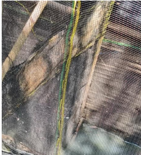
Gambar 6. Foto dinding dalam dengan lapisan waring
