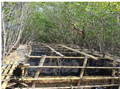
Gambar 7. Foto dinding kolam menggunakan gedeg ayaman bambu
