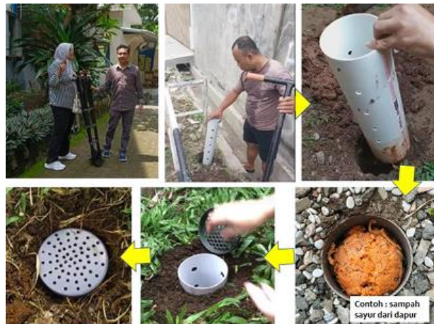
Gambar 6. Pemasangan pipa biopori oleh tim pengabdian dan warga.
