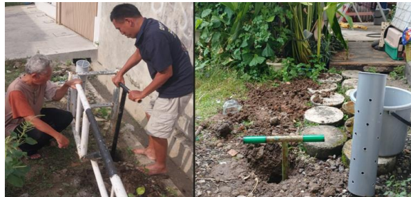
Gambar 5. Proses pengeboran tanah untuk membuat lubang biopori.
