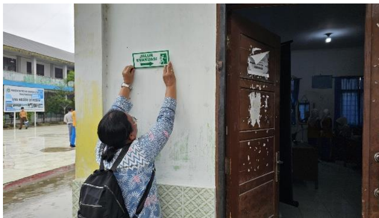
Gambar 7. Pemasangan Tanda Jalur Evakuasi (Sumber: Dokumentasi Tim PkM, 2025)
