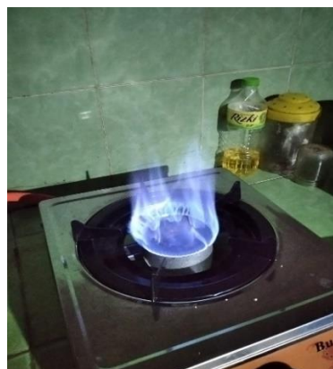
Gambar 5. Instalasi biogas siap digunakan oleh mitra sasaran sebagai sumber energi alternatif
