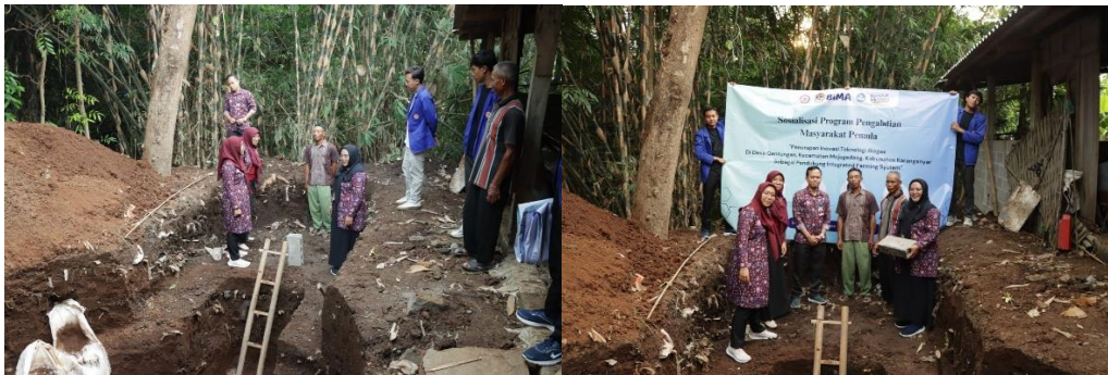
Gambar 3. Penentuan Lokasi Digester Biogas
