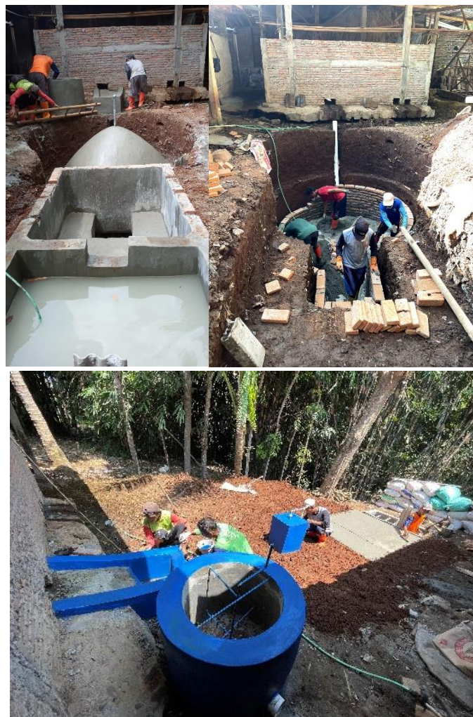
Gambar 4. Kegiatan pelatihan dan pendampingan pembuatan instalasi biogas
