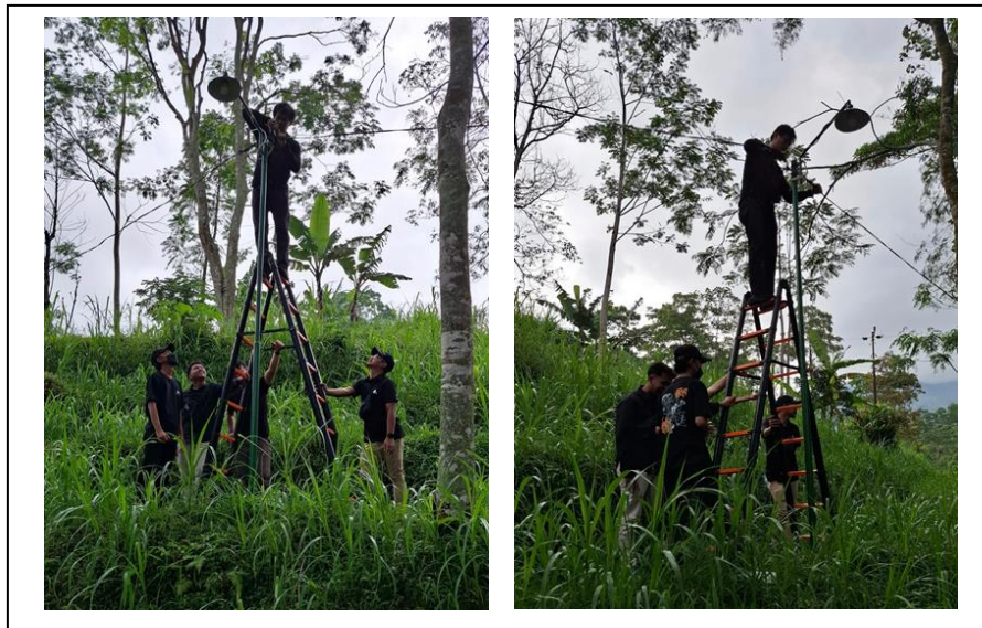
Gambar 6. Proses Pemasangan Instalasi dan Pengecekan PJU
