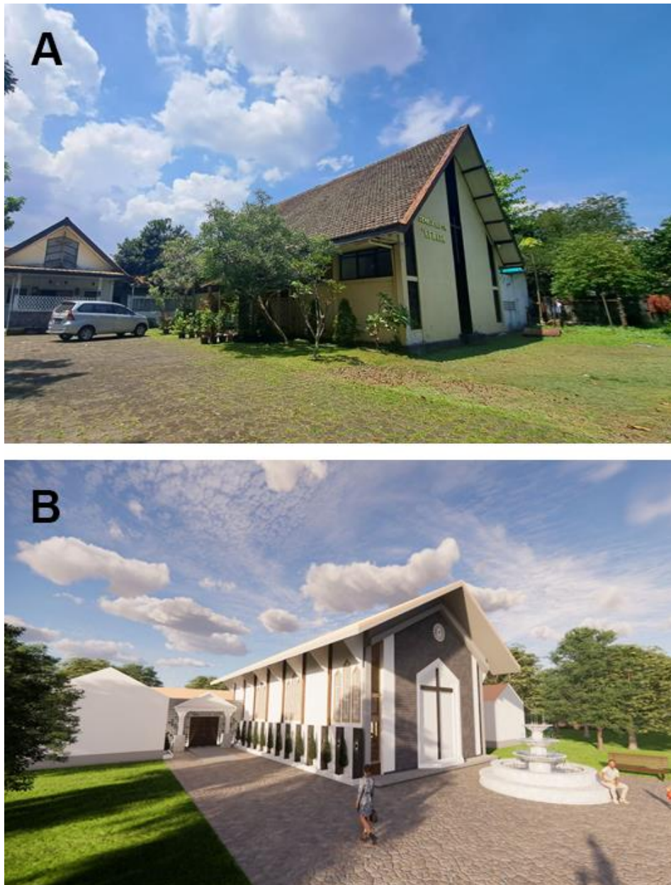
Gambar 3. Fasad eksisting gedung gereja (A). Redesain fasad gedung gereja (B). Sumber: Dokumentasi Tim Abdimas, 2023.
