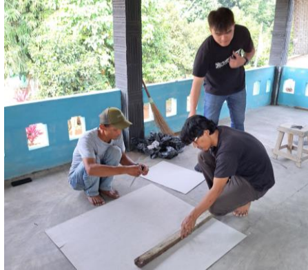
Gambar 7. Proses pemotongan plafon
