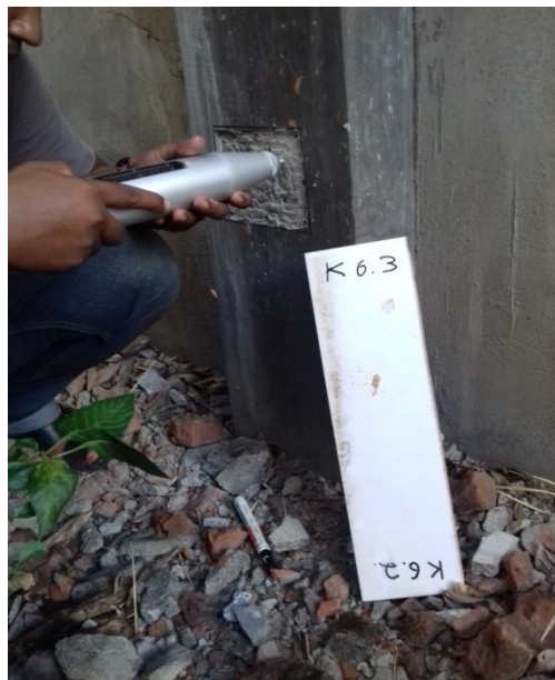
Gambar 2. Pengujian Hammer Test pada kolom Laboratorium Dinas Pekerjaan Umum, Kota Banda Aceh
