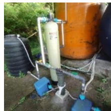
Gambar 6. Filter Sinar UV Sumber: Dokumentasi pribadi, 2025
