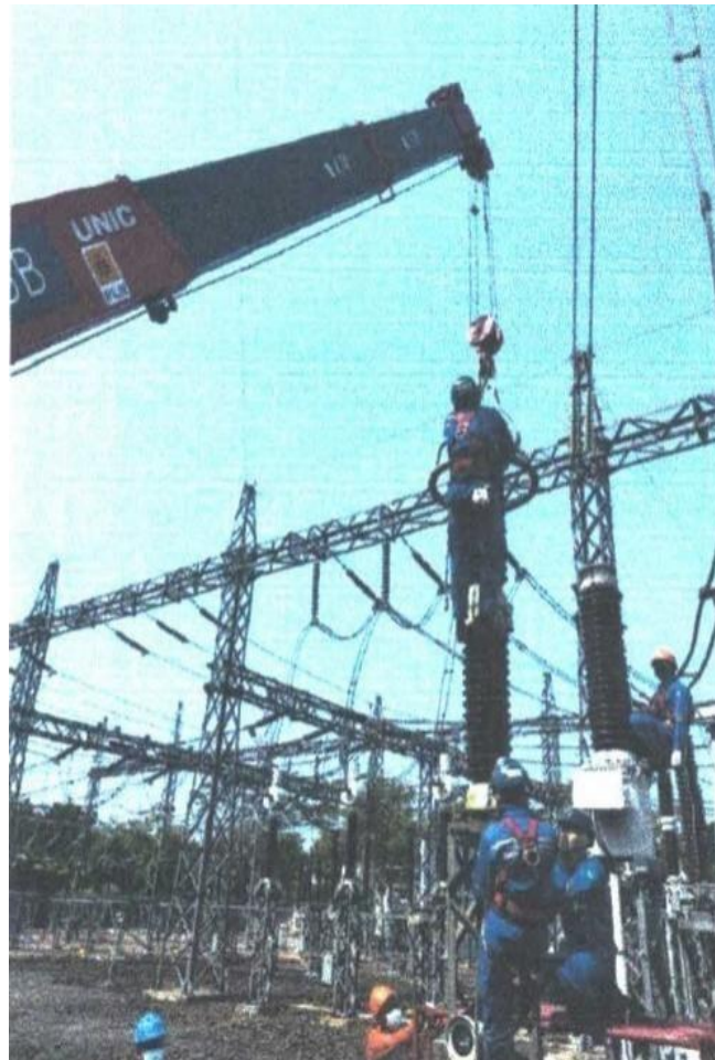
Gambar 4. Pengangkatan LA Lama Fasa R Menggunakan Crane
