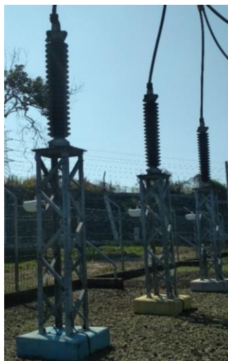
Gambar 1. Lightning Arrester Sumber: Dokumentasi Pribadi
