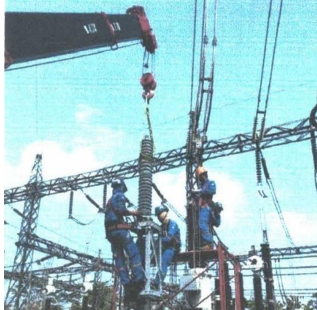
Gambar 5. Pemasangan Lightning Arrester Baru Sumber: PT. PLN ULTG Rangkasbitung
