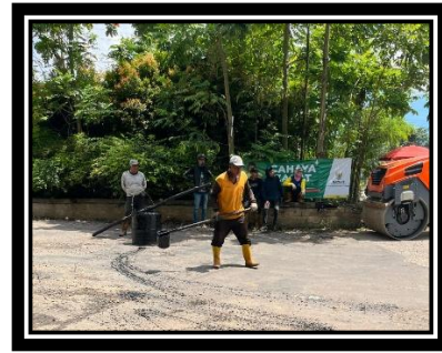
Gambar 8. Pekerjaan Track Coat
