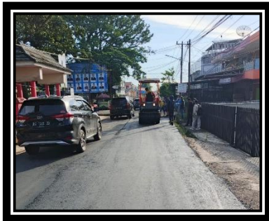
Gambar 11. Pemadatan Kedua Menggunakan Tire Roller
