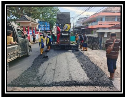
Gambar 9. Pekerjaan Penghamparan Asphalt AC-WC
