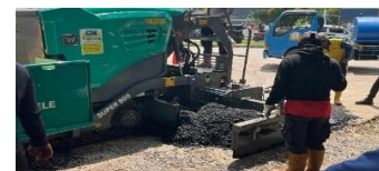
Gambar 9 Penghamparan Asphalt Sumber : Dokumentasi Pribadi 2025
