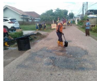
Gambar 10. Pekerjaan Tack Coat (Sumber : Dokumentasi Pribadi)
