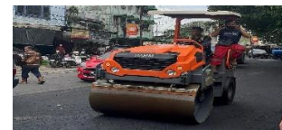
Gambar 8. Pemadatan Pertama (Sumber: Dokumentasi Pribadi)
