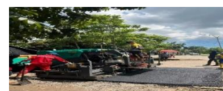
Gambar 6. Asphalt Finisher Sumber : Dokumentasi Pribadi
