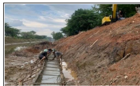
Gambar 2. Pekerjaan Beton Sloof Bawah
