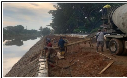
Gambar 3. Pekerjaan Beton Atas Pile Cap
