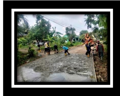
Gambar 7. Proses Pengecoran Beton Sumber: Dokumentasi Pribadi
