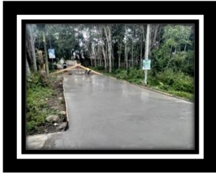
Gambar 8. Penghalusan (Grinding) Sumber: Dokumentasi Pribadi
