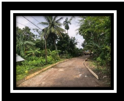
Gambar 6. Proses Bekisting Sumber: Dokumentasi Pribadi
