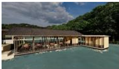
Gambar 7. Toilet dan Restoran
