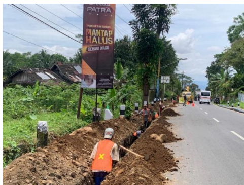
Gambar 1: Perbaikan saluran air di sekitar Lokawisata Baturraden (Sumber: Dokumentasi pribadi, 2022)
